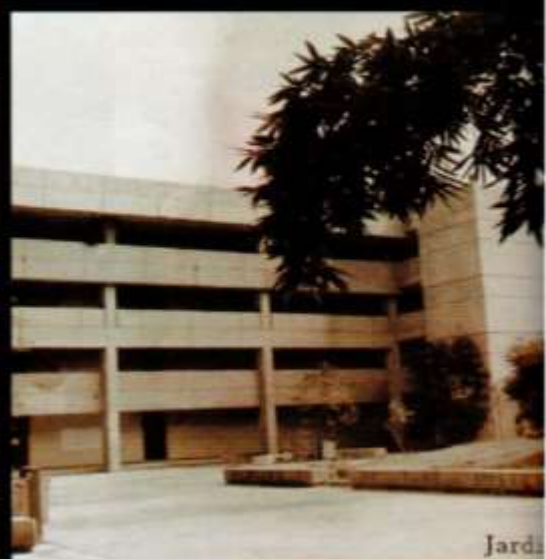
Contrucción del edificio LACE 1994
